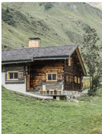
Umbau Alpgebäude, St. Antönien
